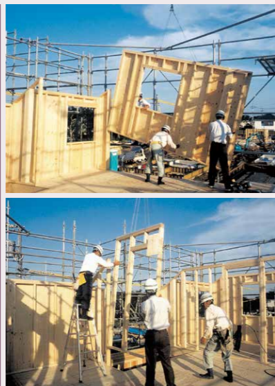
05 あらかじめ墨付けした位置に従って、2階の壁パネルを組みます。
