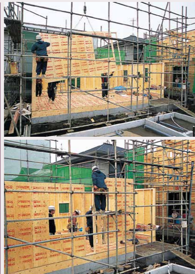
02 枠組材と構造用合板で構成される壁パネルで1階の外壁を組んでいきます。
