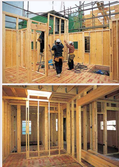
03 1階の間仕切り壁を組み上げます。
