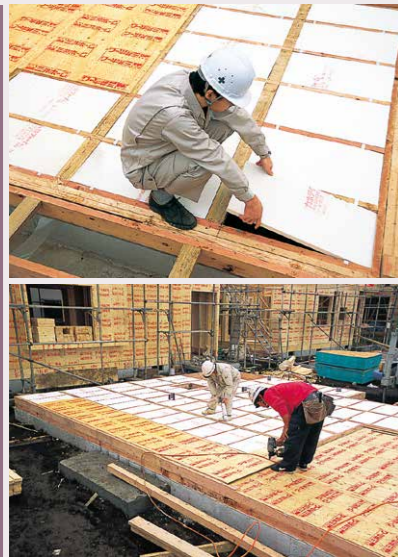
01 土台、大引きを施工し、その間に断熱材を張り込み、さらに構造用釘と接着剤を使って、構造用合板を張ります。
