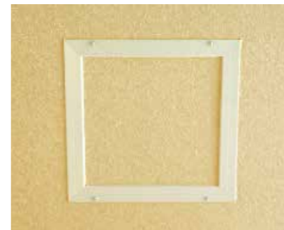
天井の点検口(例)
