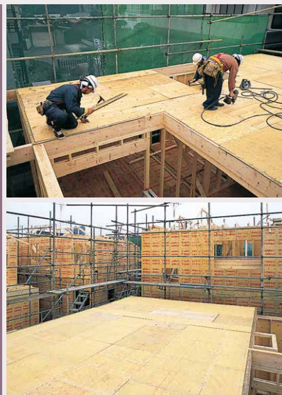
04 2階床根太は断面の大きな2×10材を組み上げ、2階床構造用合板張りを行います。
